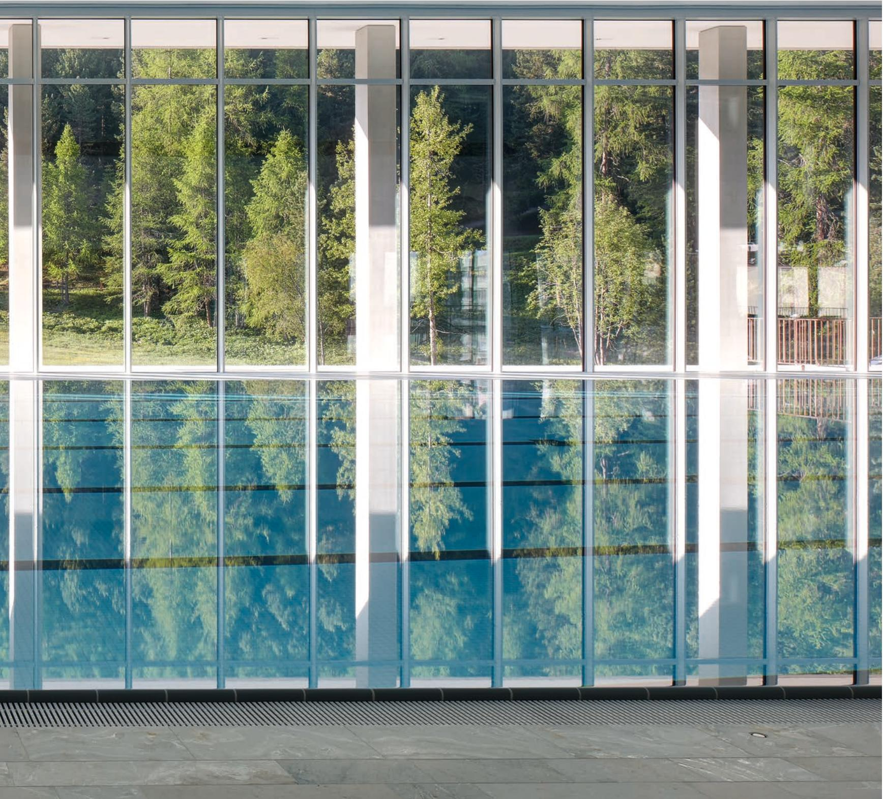
Die Glasfassade, die das Bädergeschoss in regelmässiger Einteilung umgibt, ist eine Pfosten-Riegel-Konstruktion mit einer Dreifachverglasung.
