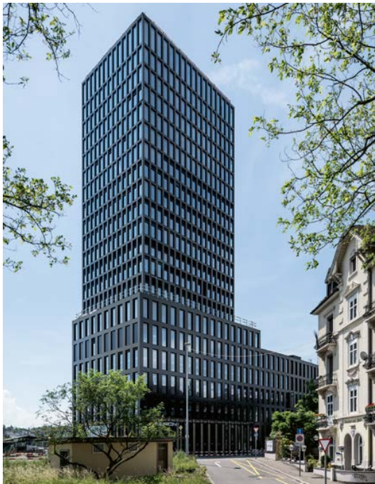
Schweizer Solarpreis 2017: Grosspeter Tower, Basel (vgl. TEC21 24–25/2017). Alle Fassaden des 21-stöckigen Hochhauses sind mit Photovoltaik bestückt, wobei die dunklen Elemente zu einer tektonisch anmutenden Hülle gefügt sind. Die 440-kW-Anlage und weitere Photovoltaikpaneele auf dem Dach produzieren total ca. 252 000 kWh/a. Daraus resultiert eine Eigenenergieversorgung von 28%.
