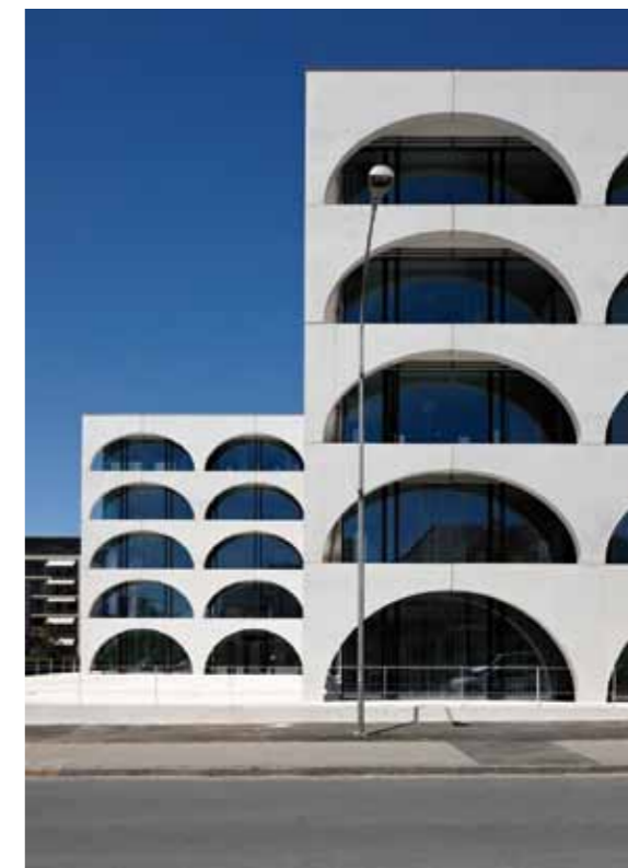
170 Bogenarkaden sind aus der Betonfassade herausgeschnitten und prägen das Erscheinungsbild des Gebäudes.
