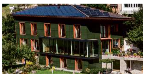
1 817%-PEB-EFH Brunner-Bapst, Waltensburg/GR: Die perfekt integrierte PV-Dachanlage erzeugt 40'200 kWh/a. Mit dem Solarstromüberschuss von 35'200 kWh/a könnten jährlich 25 Elektroautos je 12'000 km CO 2 -frei fahren. (Architekt Prof. Valentin Bearth, Chur)
