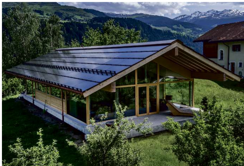
1 817%-PEB-EFH Brunner-Bapst, Waltensburg/GR: Die perfekt integrierte PV-Dachanlage erzeugt 40'200 kWh/a. Mit dem Solarstromüberschuss von 35'200 kWh/a könnten jährlich 25 Elektroautos je 12'000 km CO 2 -frei fahren. (Architekt Prof. Valentin Bearth, Chur)
