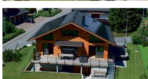
4 174%-PEB-MFH Areal, Tomils/GR 5 137%-PEB-Sanierung, Davos/GR
