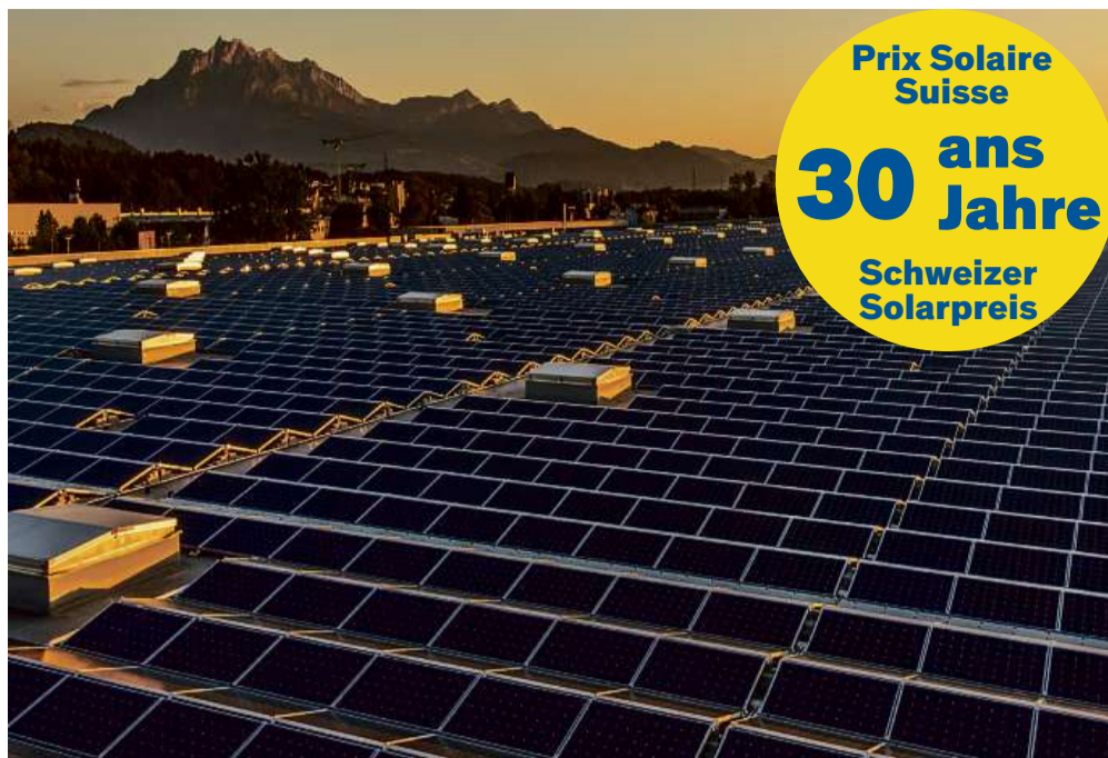
2 233%-PlusEnergie-Verteilzentrum, Perlen/LU: Das optimal Ost-West-integrierte 6.4 MW starke PV-Dach erzeugt rund 7.33 GWh/a, mehr als 4 Kleinwasserkraftwerke. Mit dem Solarstromüberschuss könnten jährlich 5'250 Elektroautos je 12'000 km CO 2 -frei fahren.
