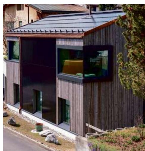
3 124%-PlusEnergie-EFH Casa Viez, Flims/GR Das EFH in Flims erzeugt mit einer ganzflächig dach- und einer fassadenintegrierten PV-Anlage jährlich 15'000 kWh Solarstrom.
